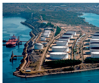
LNG terminal in Omišalj
